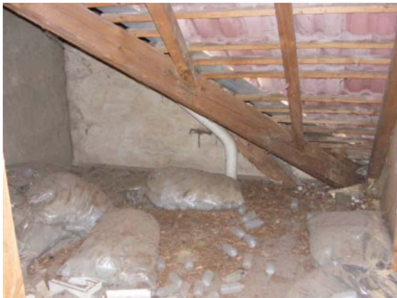
Dachboden des Nebengebäudes als potentielles Fledermausquartier mit Resten von Laborausrüstung
