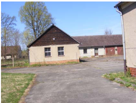
Betonflächen und artenarmer Rasen prägen die Hofsituation
