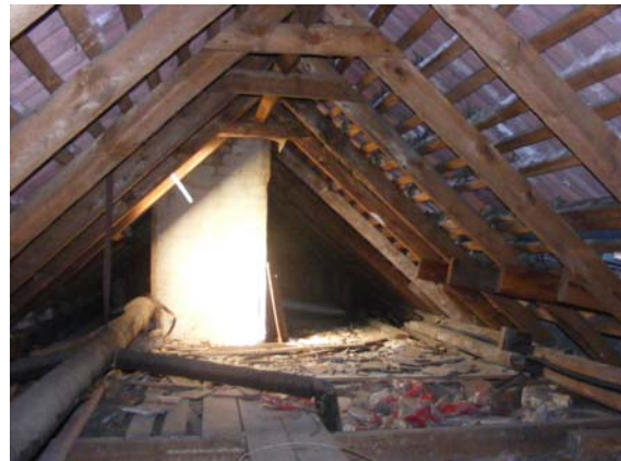
Im Spitzboden des Nebengebäudes finden sich keine Hinweise auf Fledermäuse
