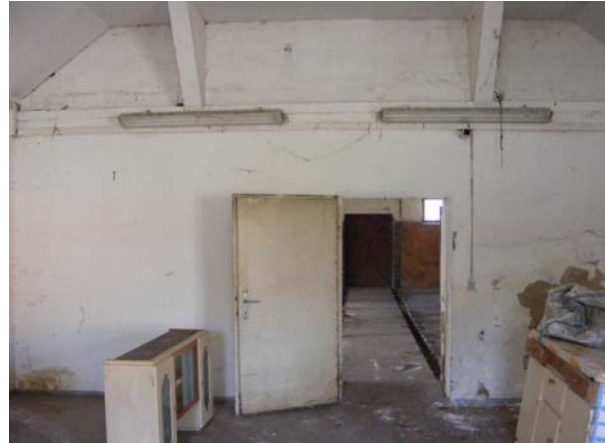
Beispielhafte Situation im Nebengebäude; die Tür führt zum Raum mit dem Nestfund
