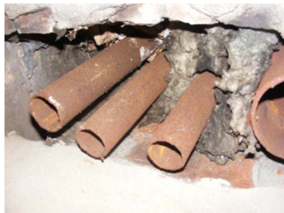
Untersucht wurden auch abgetrennte Heizungsrohre im Keller des Hauptgebäudes
