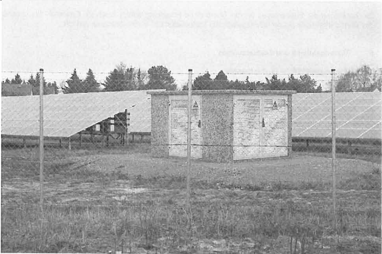
Beispiel für einen Transformator, der den Wechselstrom von 400 V auf 20 KV hochtransformiert
