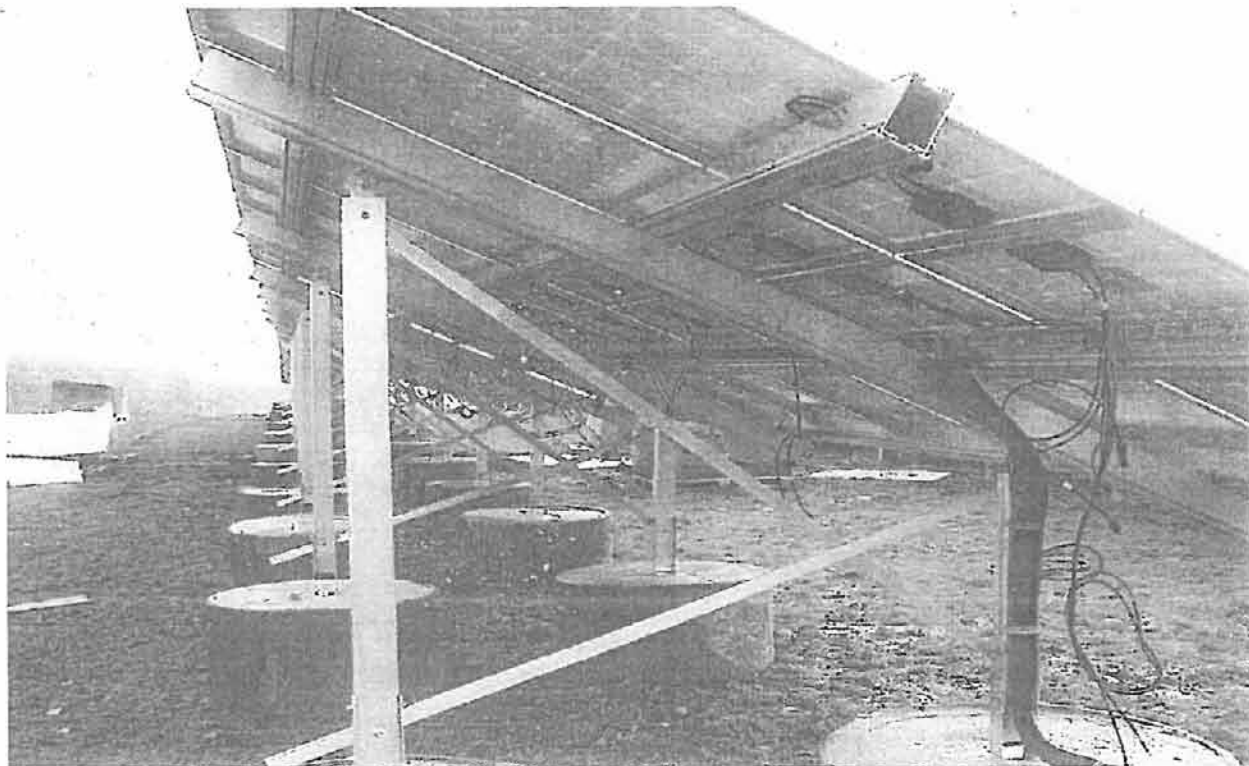
Prinzip der Flachgründung unter den Modultischen
