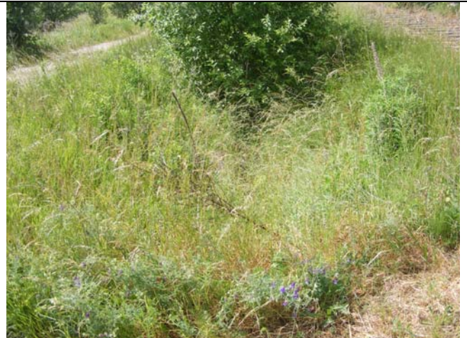
Graben zwischen aufgenommener Gleisanlage und Weg Richtung Kleingartenanlage (zur Zeit der Aufnahme nicht wasserführend)
