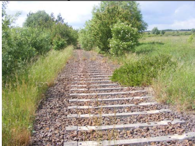
Aufgenommene Gleisanlage westlich des Plangebietes BP W23
